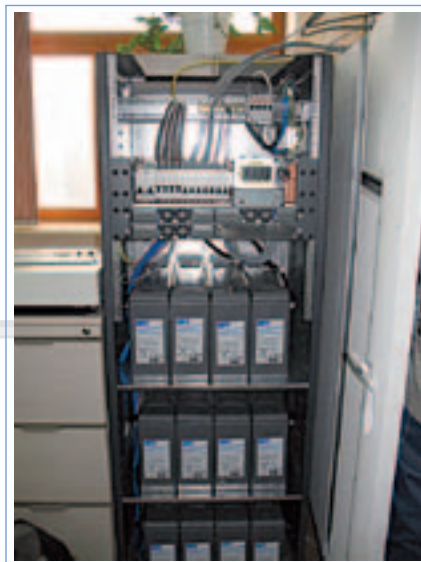
Рис. 15 Смонтированная батарея A412/120FT
