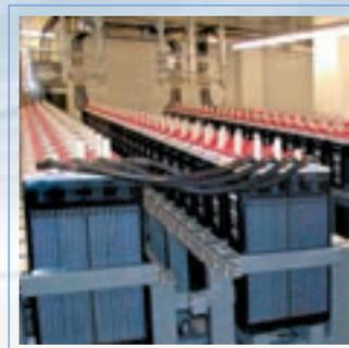
Рис. 17 Смонтированная батарея Classic OCSM
